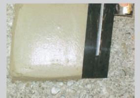
●所定の位置にモルタルを置き、十分に突き固めて下さい。
