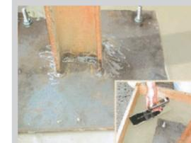
グラウト注入後、表面に出ている部分をぬれた布でカバーするか、湿して絶えず湿った状態で保持します。尚、最良の養生方法は、上記の養生をした後、露出部分のグラウトを削り取り、直ちに1:3程度のモルタルを被覆し、仕上げを行い、再びぬれた布で数日間養生します。
