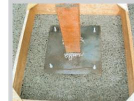
A. 適当な粗面を出し、清掃して散水し、十分に吸水させます。
