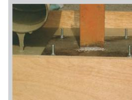
グラウトの注入にあたっては、グラウト部分の形状により、落差を利用した方法や、ポンプによる圧入工法がありますが、何れもエアが混入しないように注意し、連続して行います。
