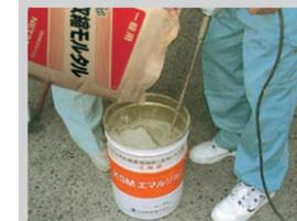
練り混ぜは必ず機械練りとし、少量 (1袋=13ℓ) の場合はハンドミキサー (回転数500~600rpmが適当) を使用し、大量の場合はグラウトミキサーを使用します。
